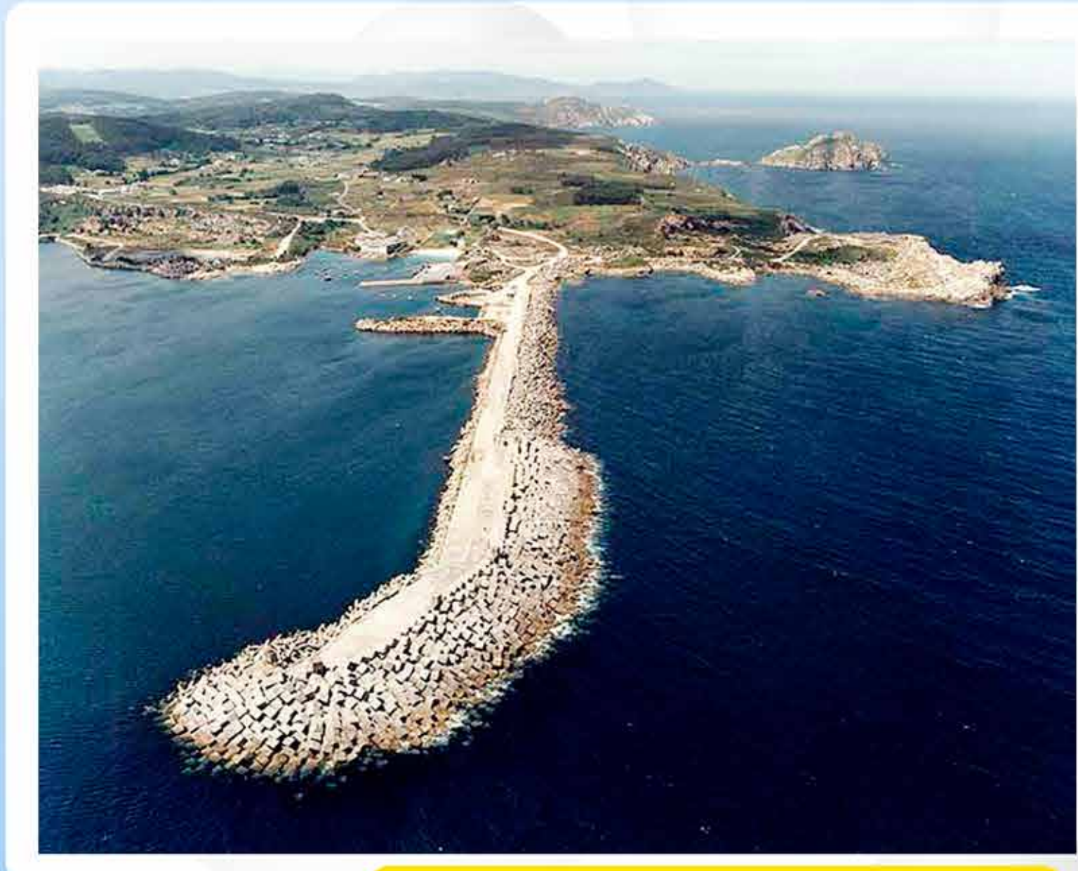
Imaxe do lugar escollido para instalar a central
